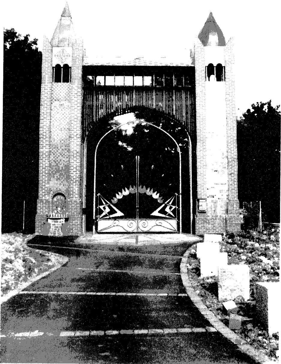
Fig. 1 The completed construction of the Big Gate of Wangen. La construction complète du Grand Portail de Wangen.
