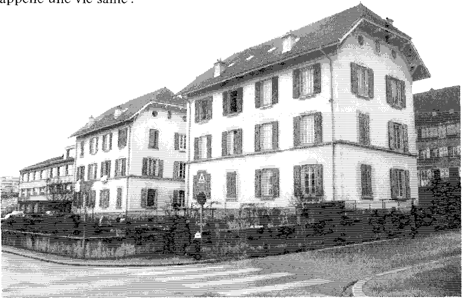
Fig. 2. Logements neufs, salubres, nets : un encouragement et un exemple. Premiers logements construits par la commune de Lausanne, 1904.
