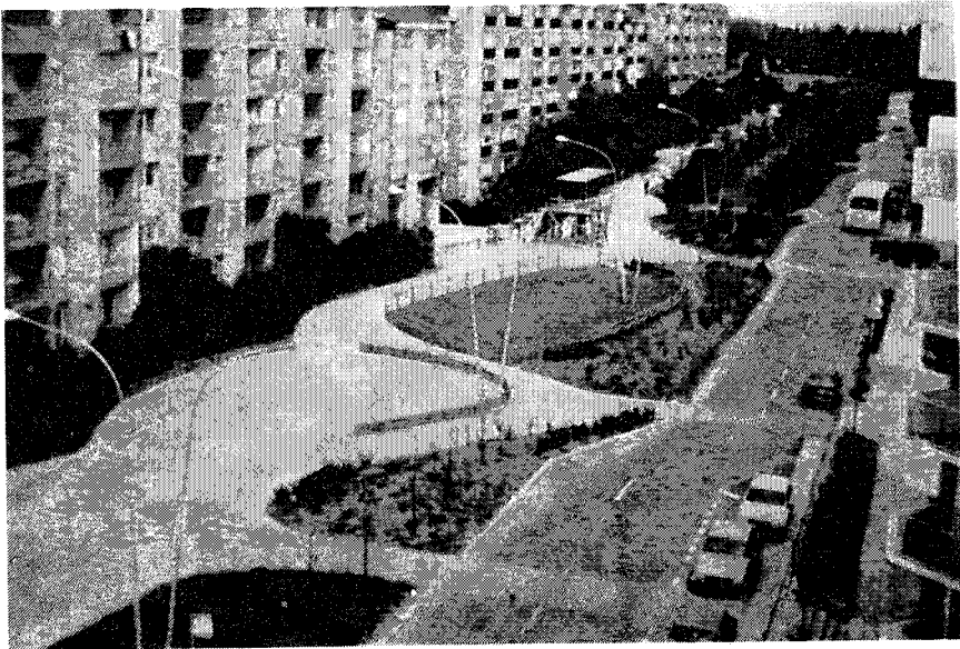
Fig. 3 et 4 La ville de Douchy les Mines, dans la région Nord-Pas de Calais, a beaucoup été citée, parmi les urbanistes, pour avoir transformé le "boulevard de la Liberté", artère rectiligne à quatre voies, en un vaste parc entre les immeubles: la circulation y garde ses droits mais se régule dans des tracés nouveaux de voies ramenées à de justes dimensions.
