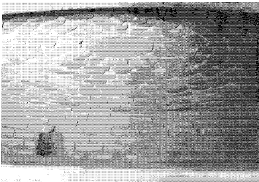
Fig. 2. Vue intérieure de la coupole surbaissée du four à pain. Interior view illustrating the flattened dome of the bread oven.
